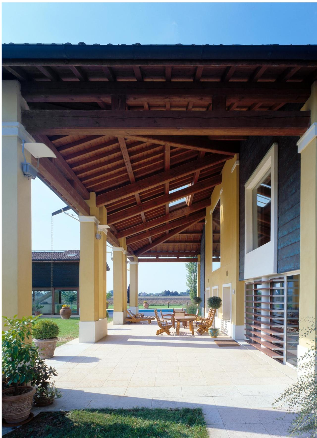
*Fig. Restauro di una corte in provincia di Modena; Con la nuova copertura utilizzando le travi "Uso Fiume" è stata recuperata una zona all'aperto protetta dalle intemperie; ©Rete Uso Fiume ed Uso Trieste.*
