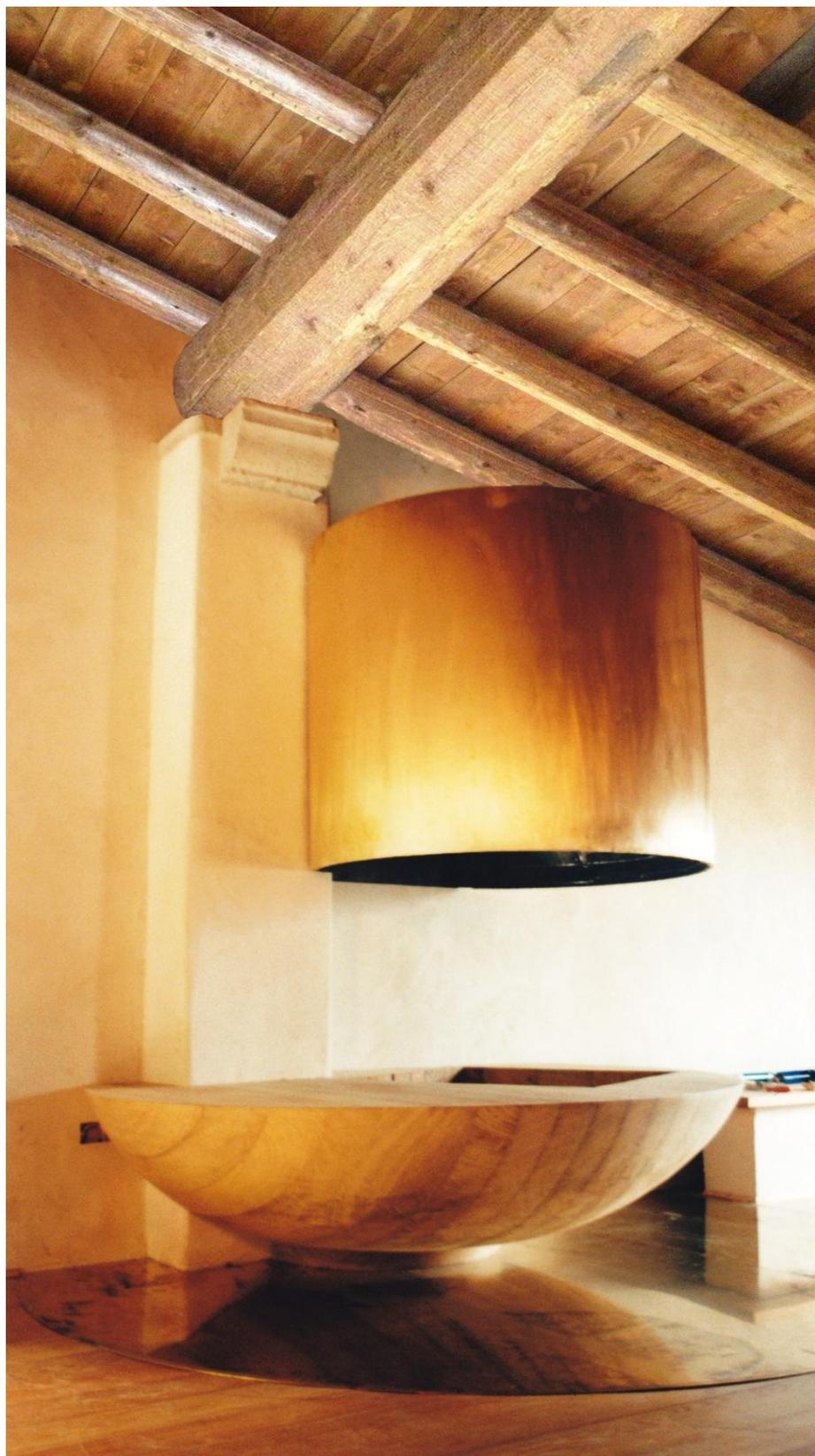
*Fig. Nuova copertura in travi di abete "Uso Fiume" per il restauro di un edificio del XVIII secolo sul Lago di Garda.*
