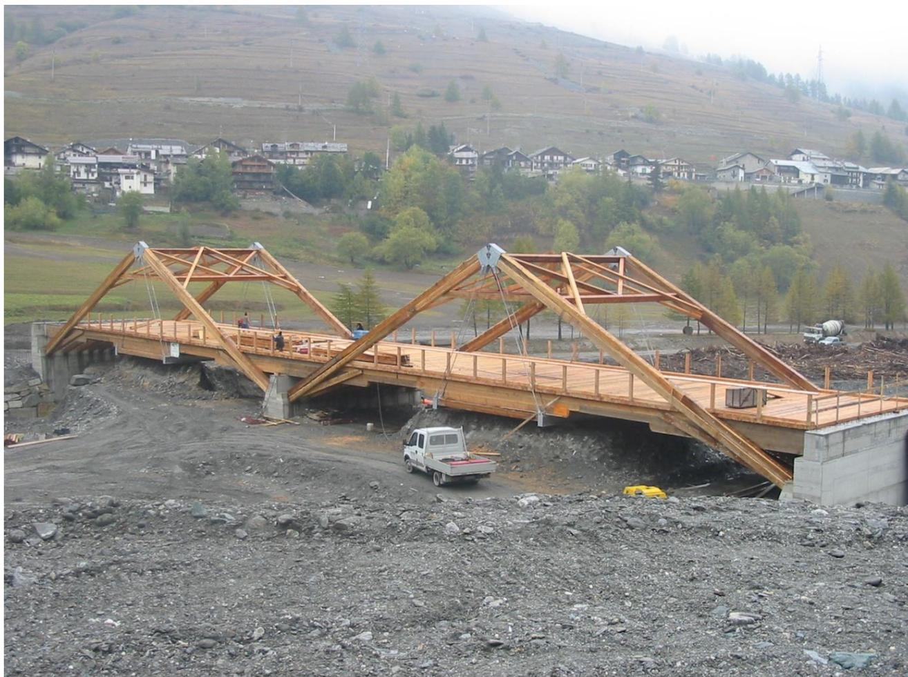
*Fig. Utilizzo delle travature "Uso Fiume" ed "Uso Trieste" per la costruzione di un ponte per il centro sci di fondo e Biathlon per i XX Giochi olimpici invernali a Pragelato/ Torino (I); lignaconsult- Bolzano (BZ).*
