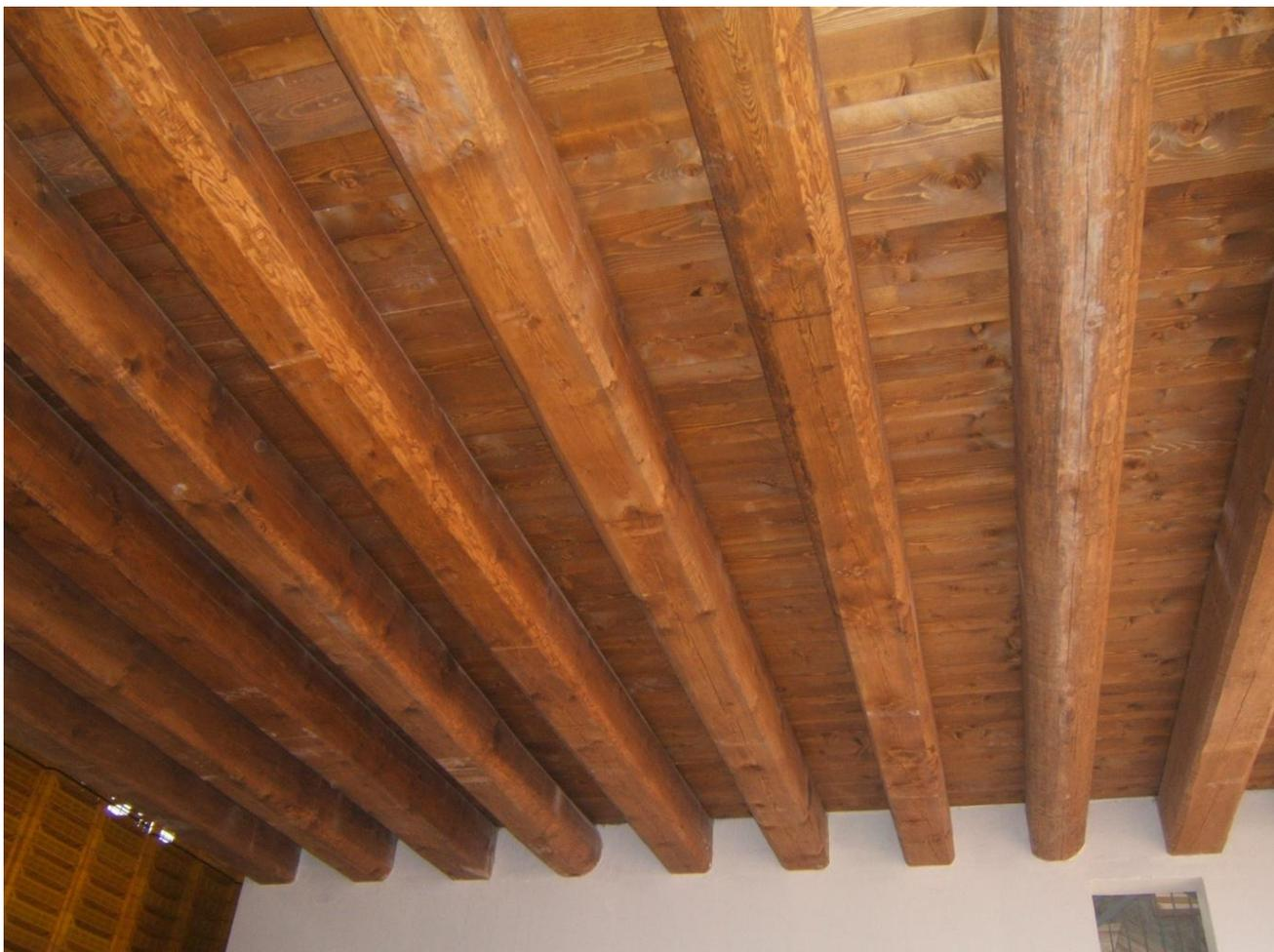
*Fig. Solaio con travature "Uso Fiume"; ©Rete Uso Fiume ed Uso Trieste.*
