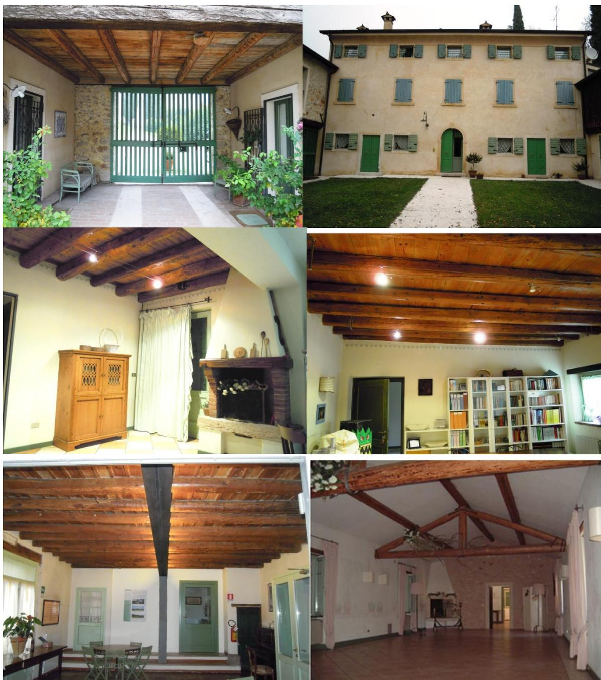
*Fig. Restauro di una corte veronese del 1800. I solai realizzati con travi in abete "Uso Trieste", sono stati restaurati sostituendo le travi ammalorate con travi nuove successivamente trattate con prodotti naturali per uniformarle alle preesistenti; MRC Calliari Engineering - Zevio (VR).*
