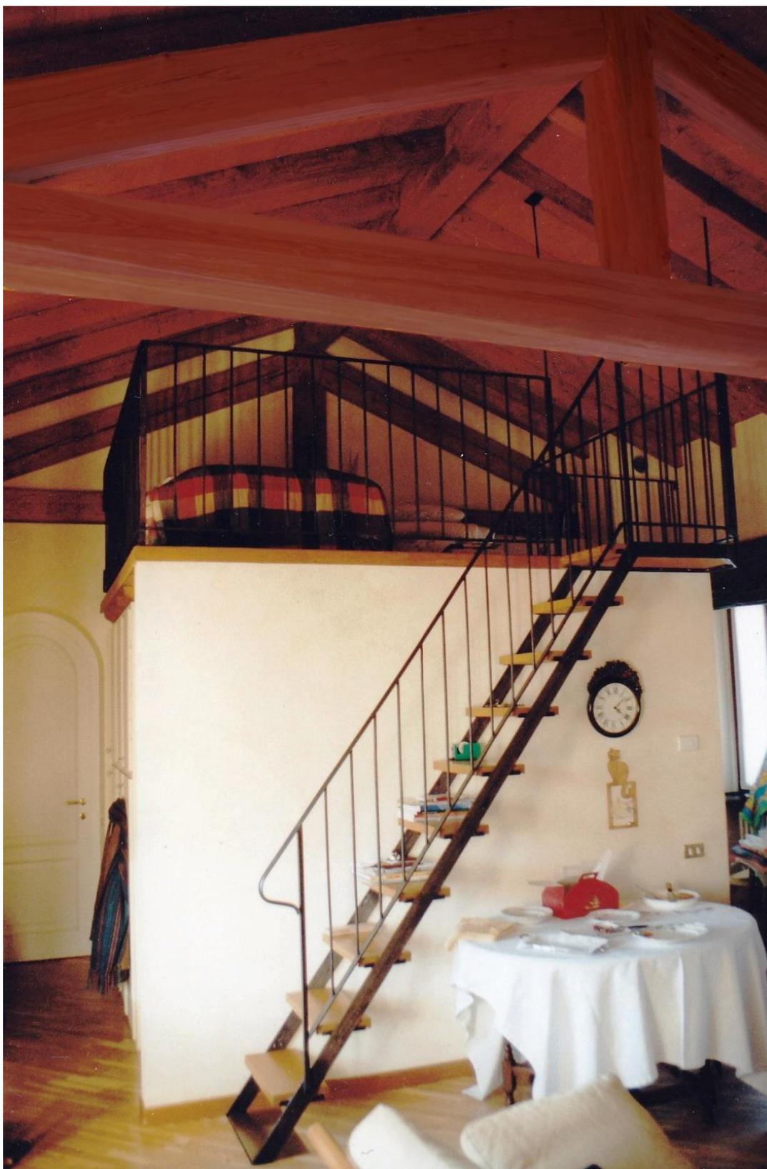
*Fig. Restauro di corte rurale storica del XVIII secolo in Brianza. Copertura in legno di abete con capriate realizzate con travi "Uso Fiume". L'ambiente è caratterizzato dall'inclusione tra le due capriate, di un volume dalle linee semplici con funzione di soppalco che contiene la zona cucina su un fronte, e un bagno di servizio su quello opposto; MRC Calliari Engineering - Zevio (VR).*
