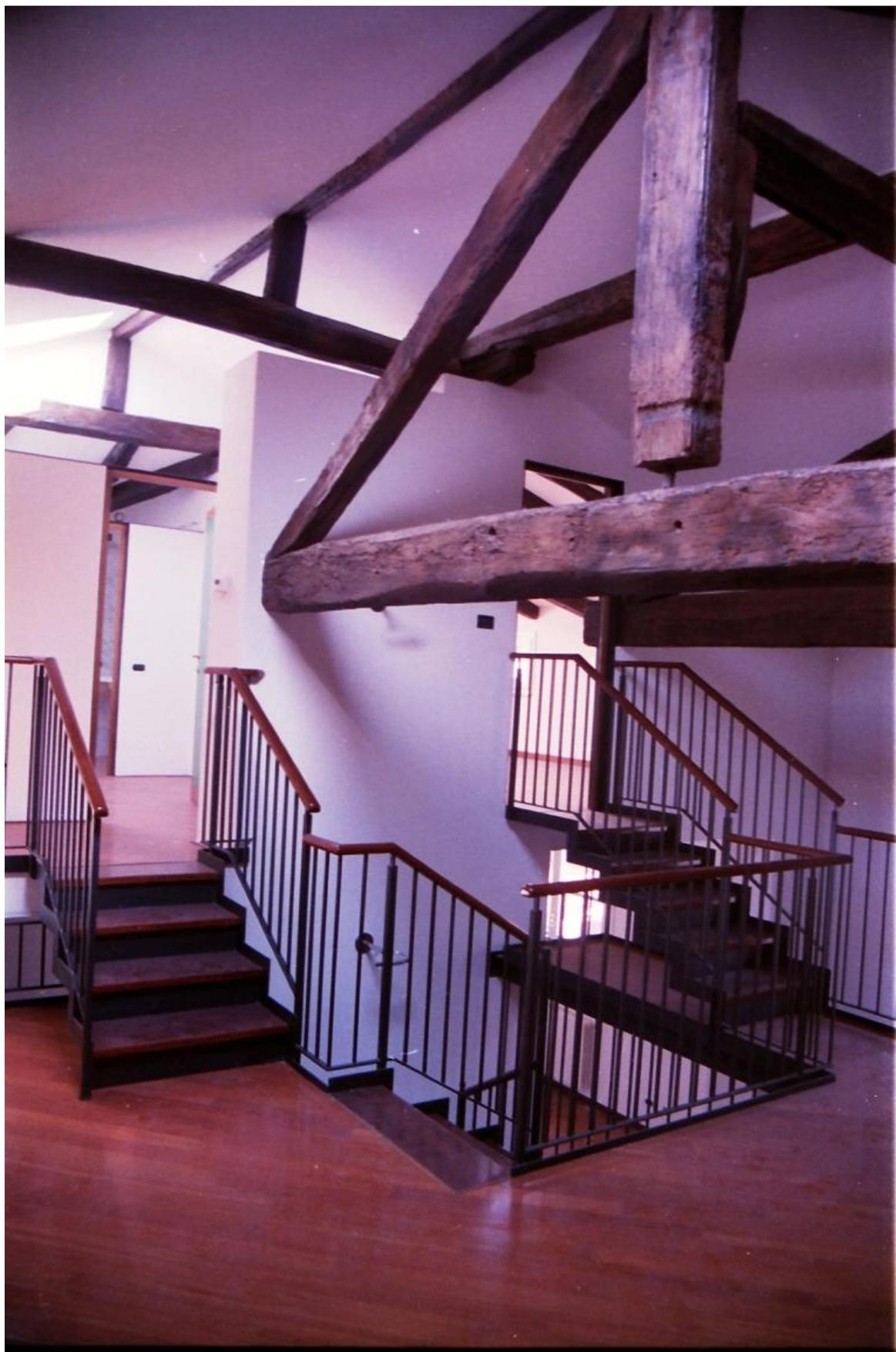
*Fig. Le capriate sono lavorate con le tecniche antesignane della trave "Uso Fiume": cioè squadrata con piani paralleli e spigolo smussato.; MRC Calliari Engineering - Zevio (VR).*
